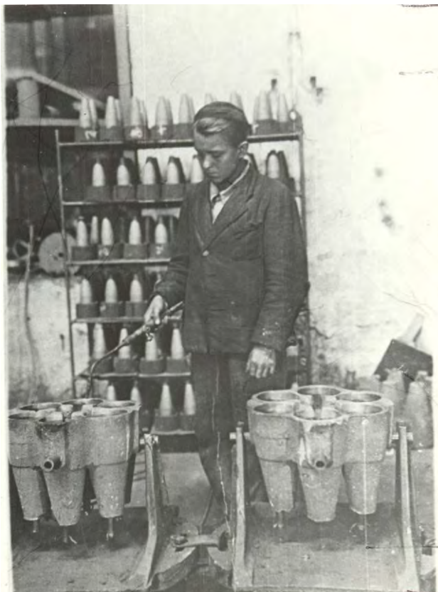
Подготовка форм для отливки корпусов мин
