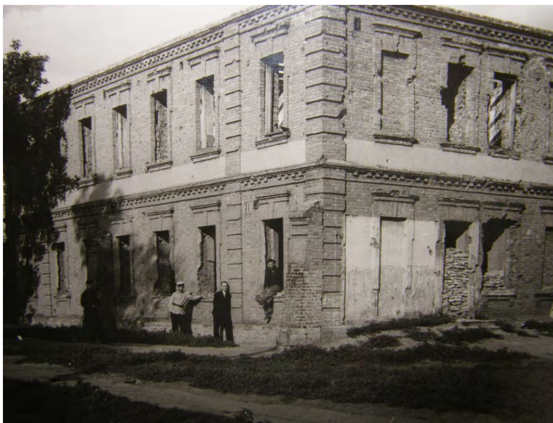
Разрушенное общежитие Тихорецкого ж/д техникума
