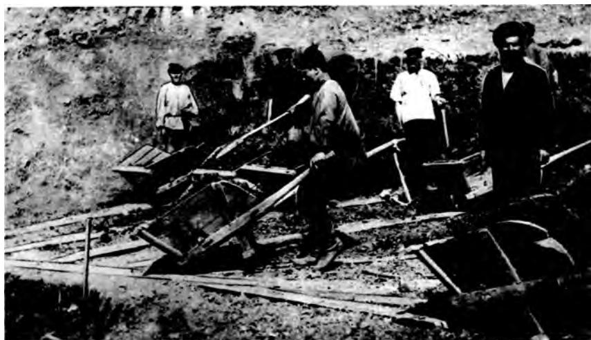
На строительстве земской дороги. Фото А.А. Макаревского. 1910-е годы.
