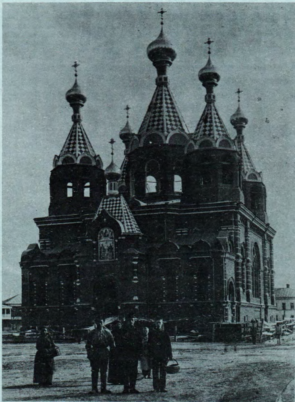
Собор Александра Невского в центре г. Макарьева. Снимок сделан в 1904 году, когда храм строился. Сейчас здесь кинотеатр, но уже пришло время нового строительства и возрождения этого святого места.
