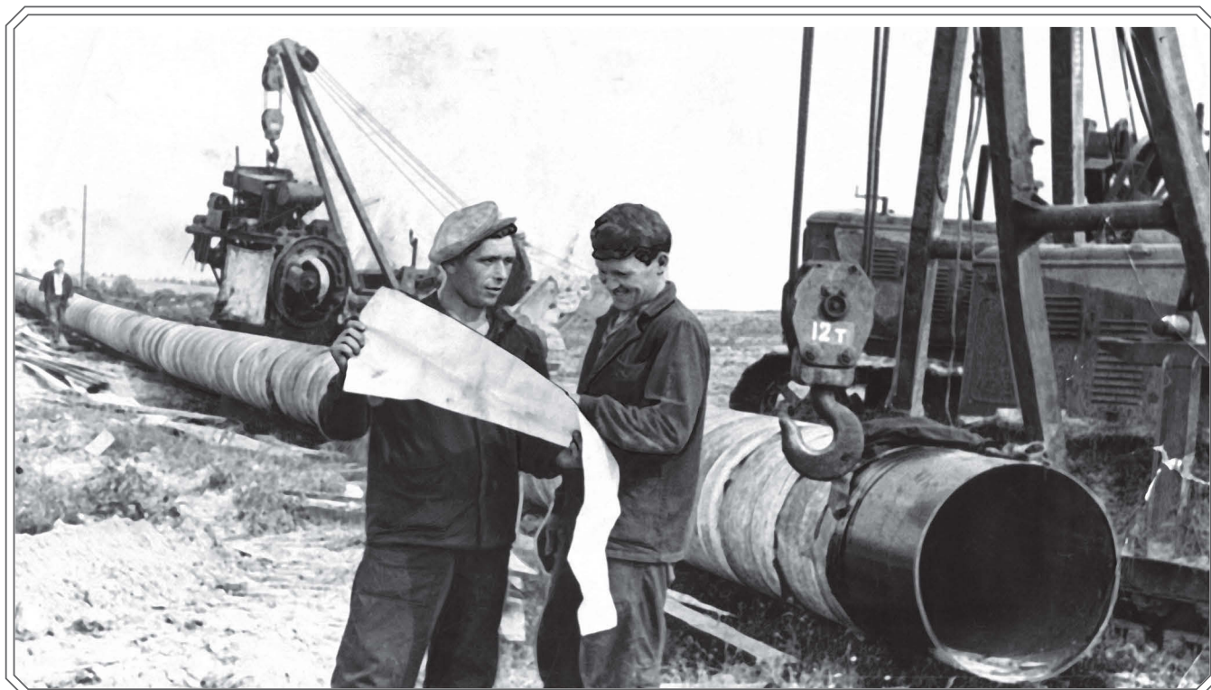
Ударная комсомольско-молодежная комплексная бригада В.М. Гусева на прокладке газопровода к Костромской ГРЭС. 1970 год.
