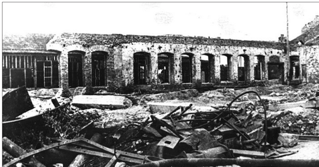
Гомельский вагоно-ремонтный завод. Работает в настоящее время, ремонт вагонов для БелЖД и РЖД.
