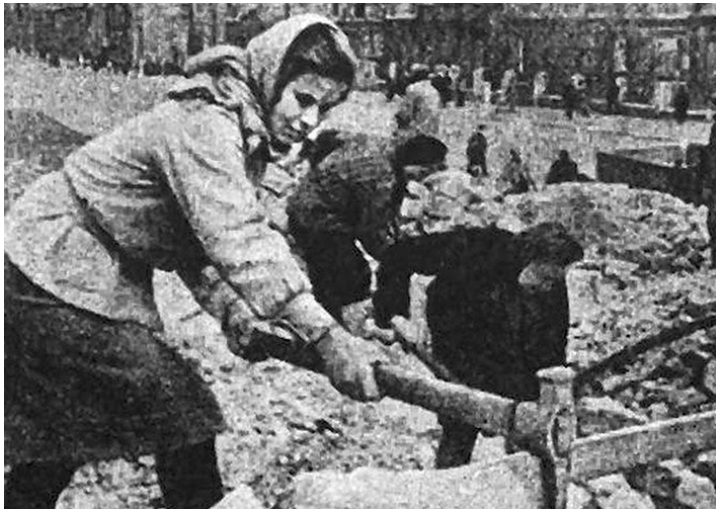
Женщины на восстановлении железнодорожной станции Гомель.
