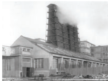
[4] Чулочно-трикотажная фабрика «Красное Знамя» (ул. Кр. Курсанта, 25) с эффектной башней силовой подстанции.
