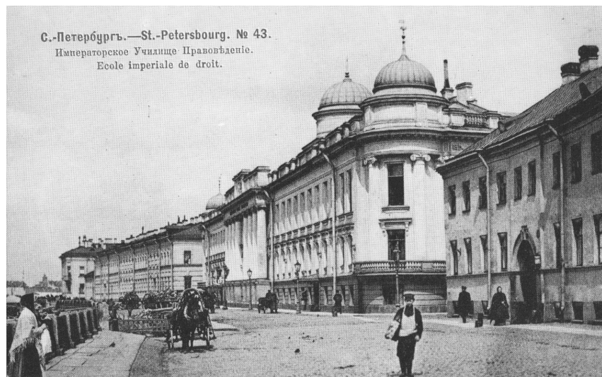
Здание Императорского училища правоведения. Наб. р. Фонтанки, 6
