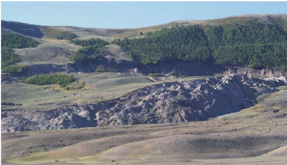
Рис. 1. Внешний вид гигантского обвала-оползня в бассейне р. Талдура.
