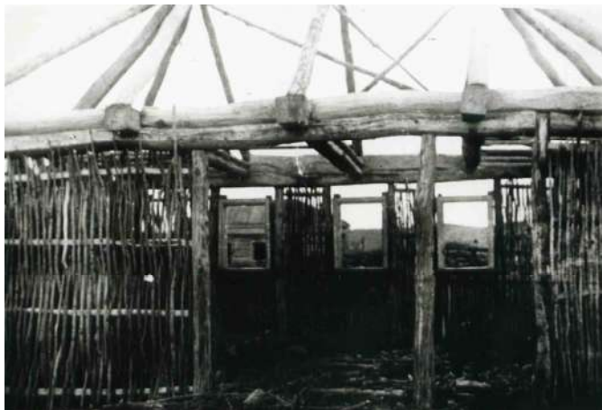
Фото 11. Технология постройки турлучной хаты, с. Богомолвка, Белебеевский кантон, 1930 г.
