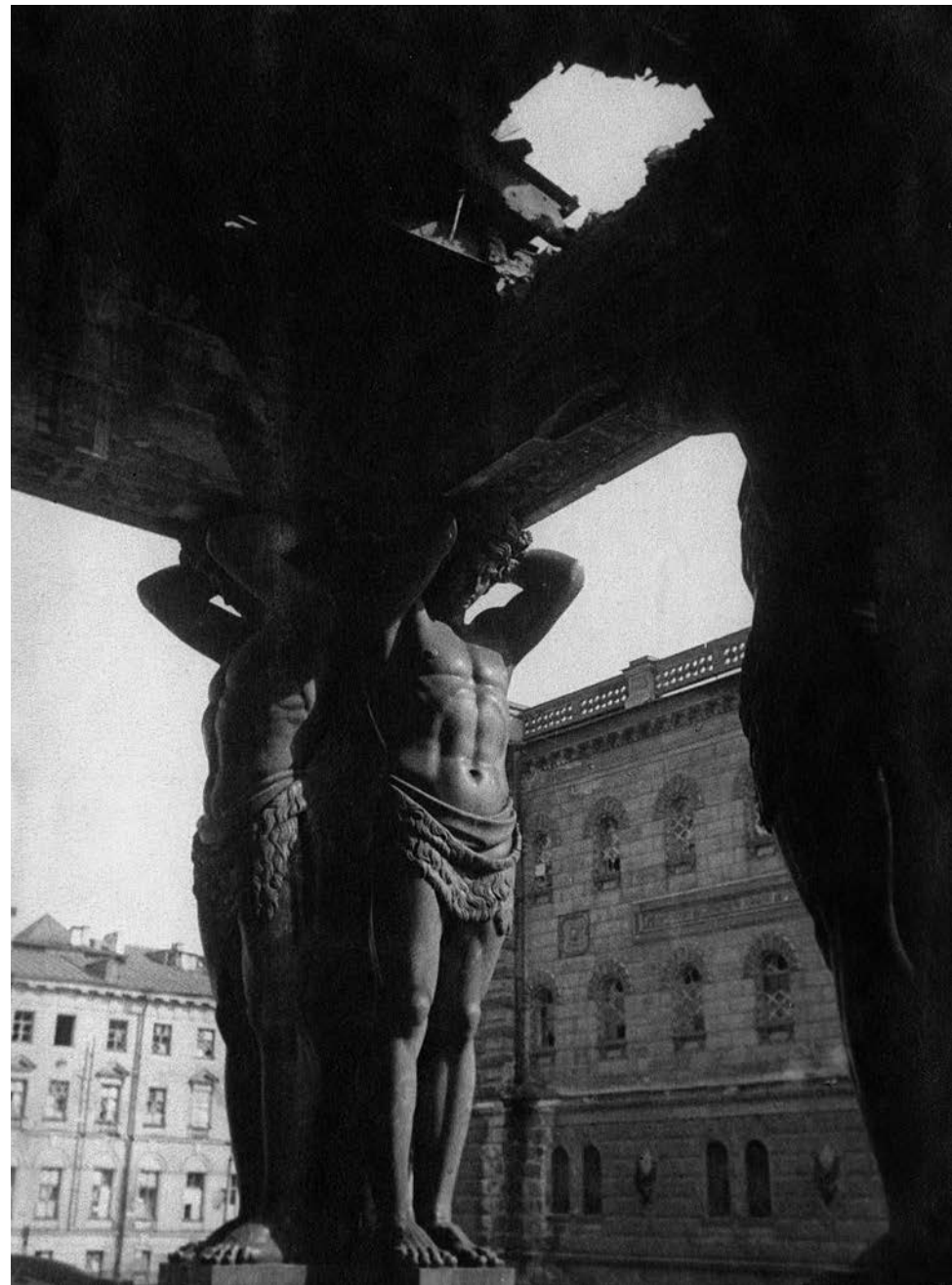
Халтуринский подъезд Нового Эрмитажа после артобстрела. Фото из Архива ГЭ
