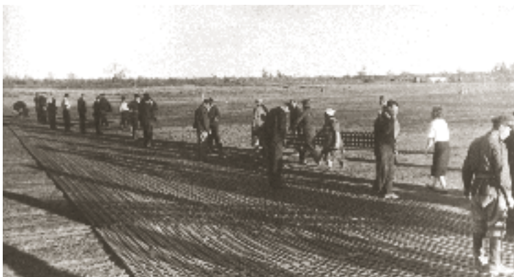
Укладка металлической ВПП на аэродроме Марково
