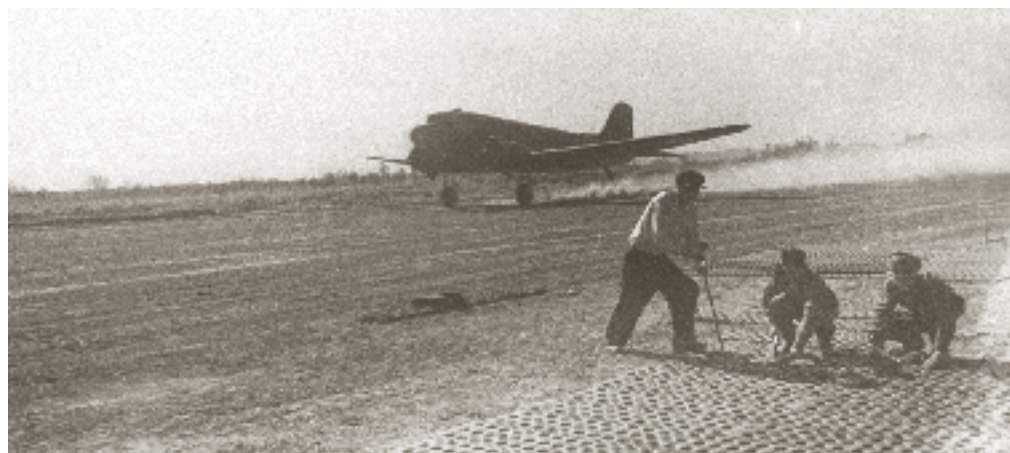
Не смотря на укладку металлических плит на ВПП, полеты не прекращались ни на минуту
