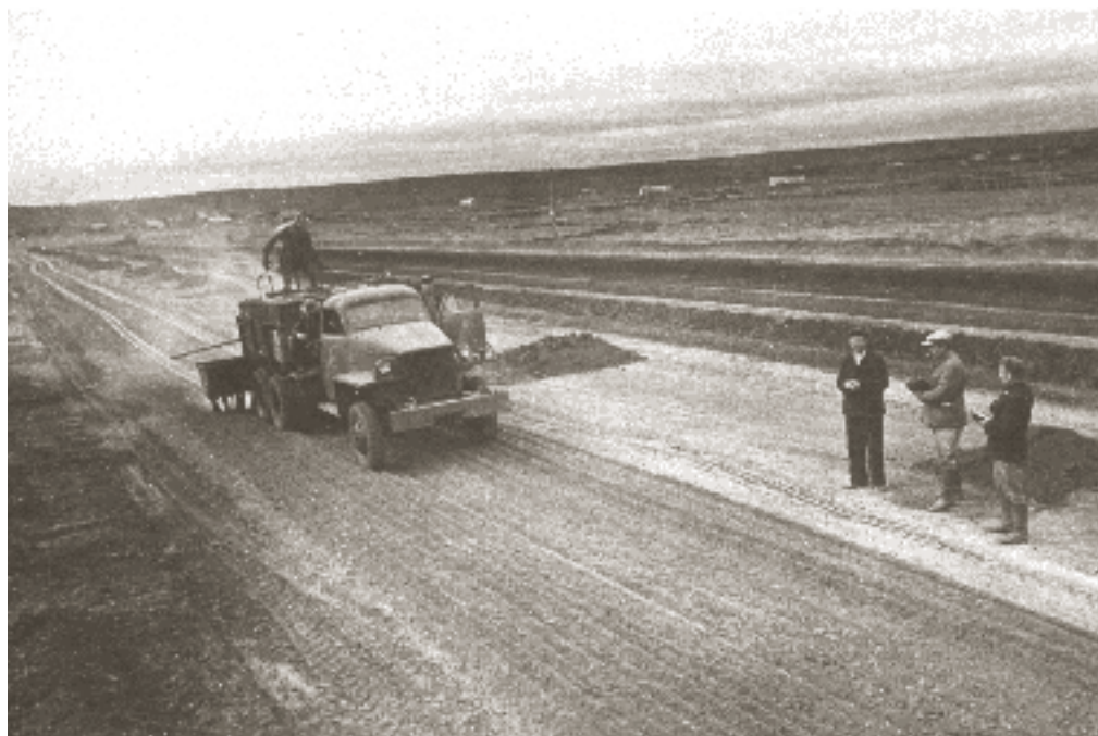
Строительство аэродрома. Гудронирование ВПП
