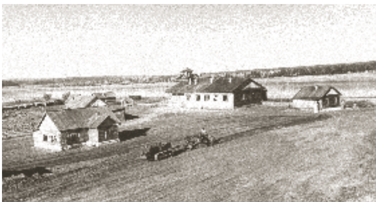
Строительство здания аэропорта
