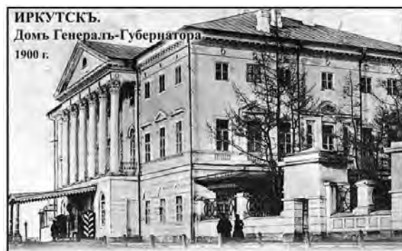
Иркутск. Дом генерал-губернатора.
