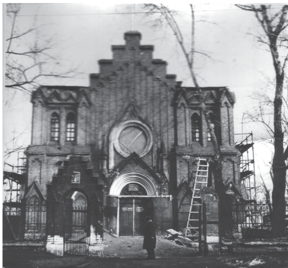
Здание до реставрации 1982 г.
