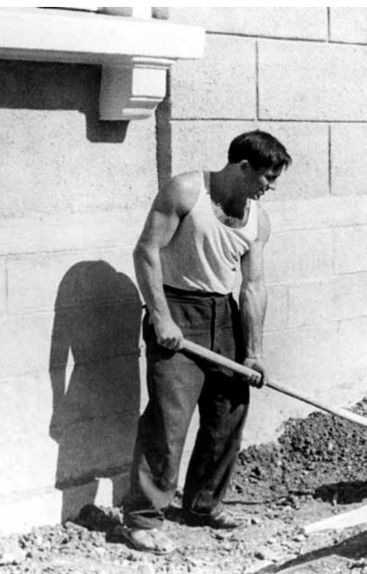
Благоустройство территории перед главным зданием Института
