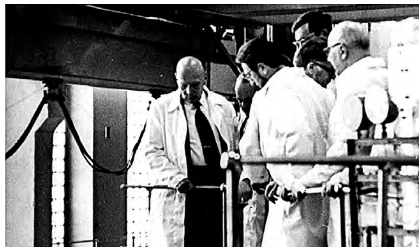
Президент АН СССР А.П.Александров, Б.Н.Гощицкий и С.К.Сидоров на верхней площадке реактора ИВВ-2
