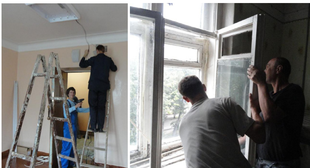
Ремонт в общежития выполняют как работники административно-хозяйственных служб, так и сами студенты
