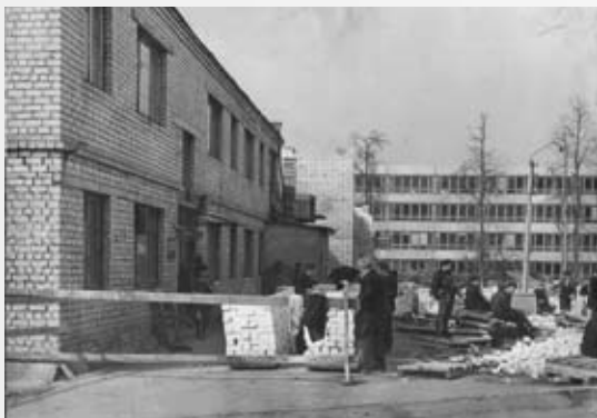
Строительство здания НИИ Механики
