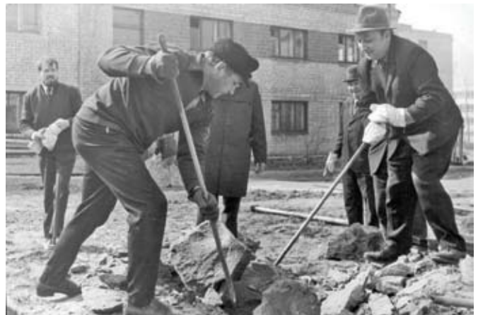
А.Г. Угодчиков на строительстве здания НИИ механики
