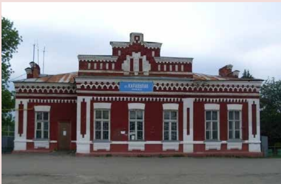
Здание вокзала станции Карабулак Рязано-Уральской железной дороги. 2010 г.
