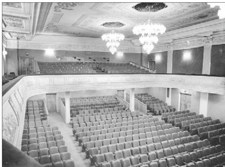
Театральный зал после реконструкции. 1980-е годы
