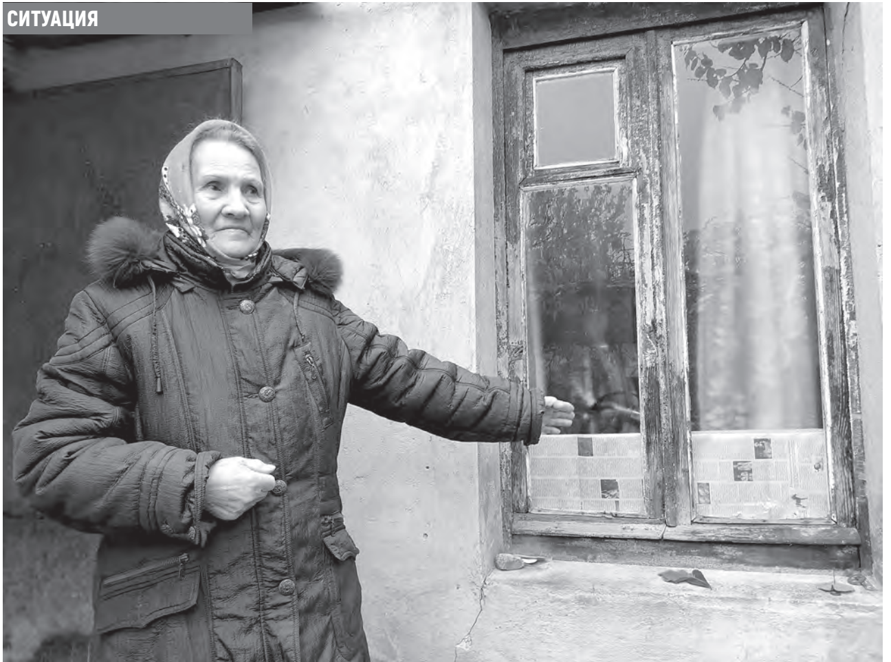
Жительница дома № 38 по улице Героев обороны Брестской крепости Надежда Трихонюк демонстрирует изъяны своего жилища.
