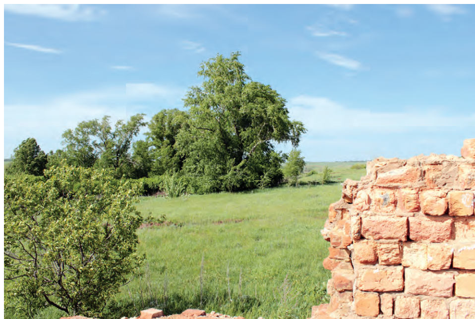
Фундамент дома в усадьбе Карамзиных Преображенка (Михайловка, Карамзиха). Вид с юга. Фото Ек.В. Мишаниной. 2013 г.
