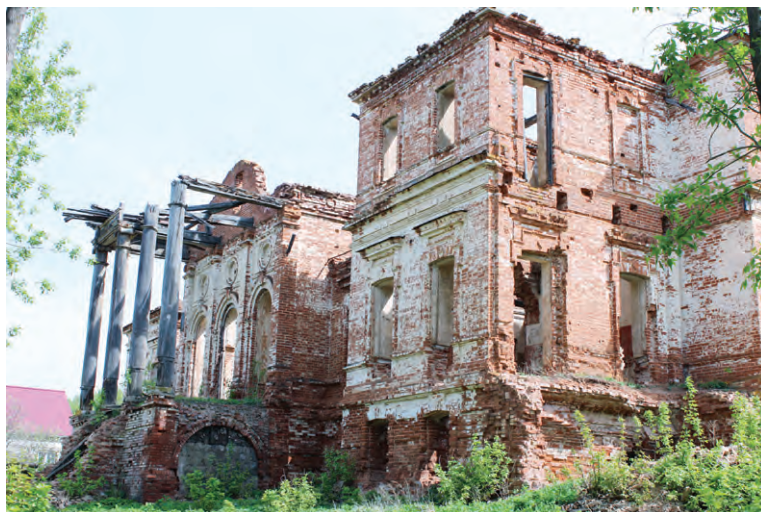
Кирпичный дом Рычковых в усадьбе Савруша-Студенец (с. Рычково Северного района Оренбургской области). Первая половина XIX в. Вид с юго-востока. Фото Ек.В. Мишаниной. 2012 г.
