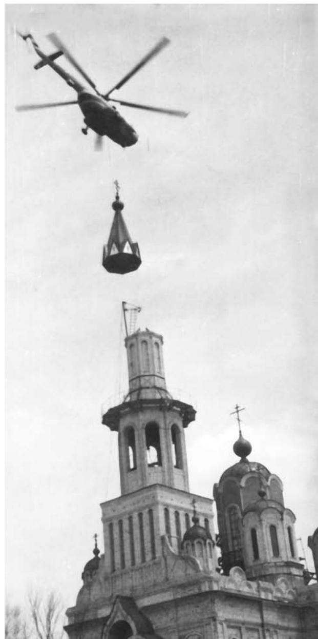
Монтаж купола церкви в г. Невинномысске выполняют зам. к-ра АЭ Шаталов Д.И., ПИ Рыжгий А.М.
