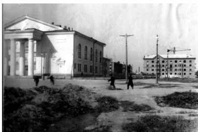
На фотографии: строительство домов рядом с Дворцом культуры, 1957 г.
