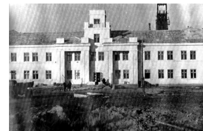
На фотографии: строительство шахты № 1
