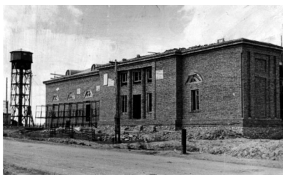
На фотографии: строительство кинотеатра «Шахтер»
