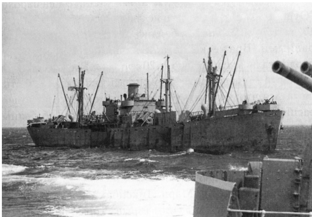
Еще одно судно типа «либерти», на носу и на корме видны площадки с зенитными пушками
