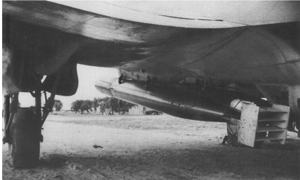
Авиационная торпеда F5, подвешенная под центропланом He-111H-6 из KG26
