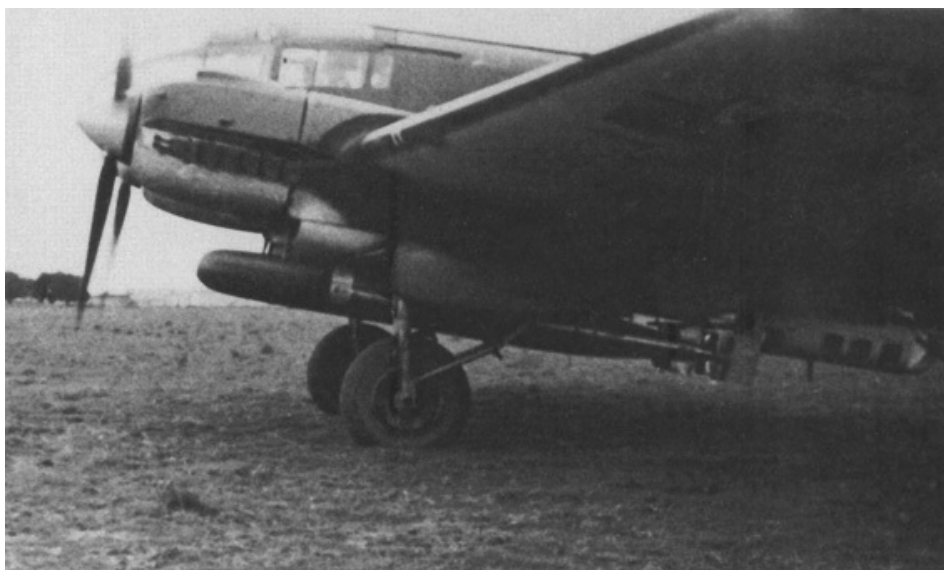
He-111H-6 из KG26 с двумя подвешенными авиационными торпедами F5
