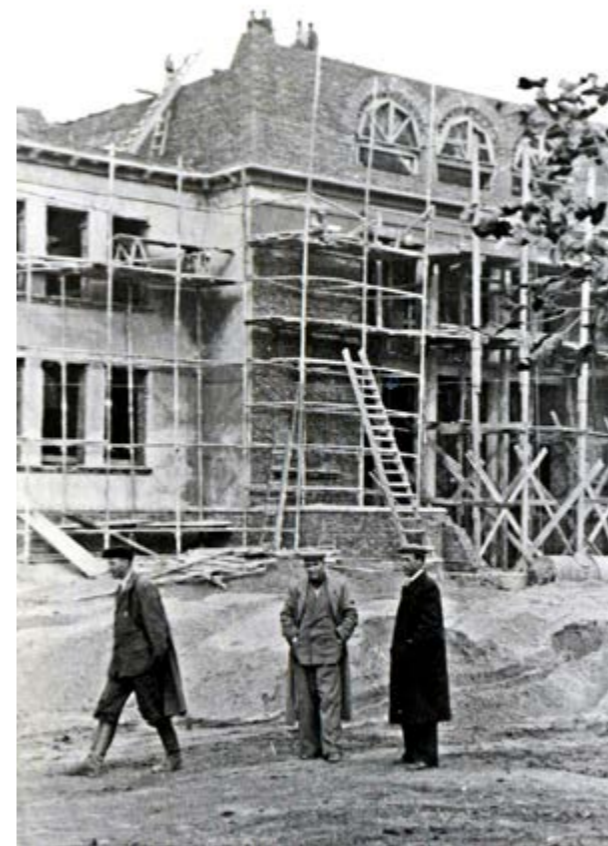
Строительство дома культуры. Фото 1957 года
