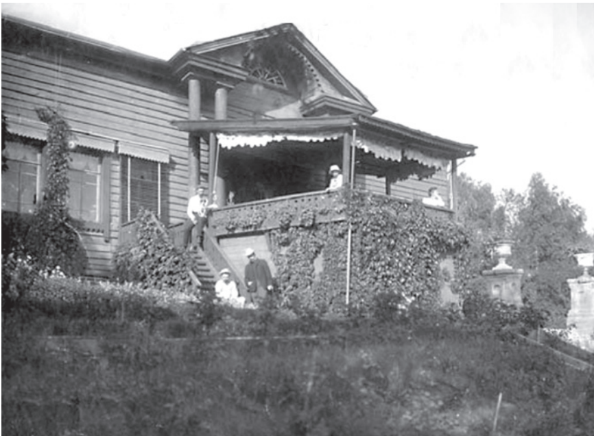
Дом А.Н. Островского. Южный фасад. Нач. XX века.
