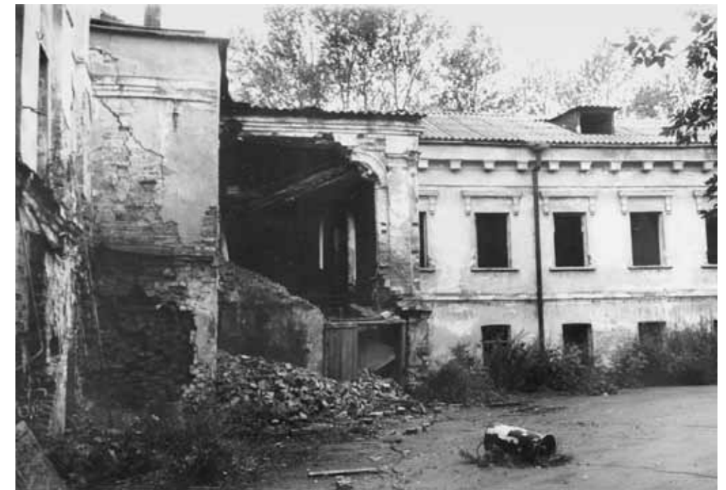
Разрушенные постройки на территории Введенского женского монастыря. 1988 г.
