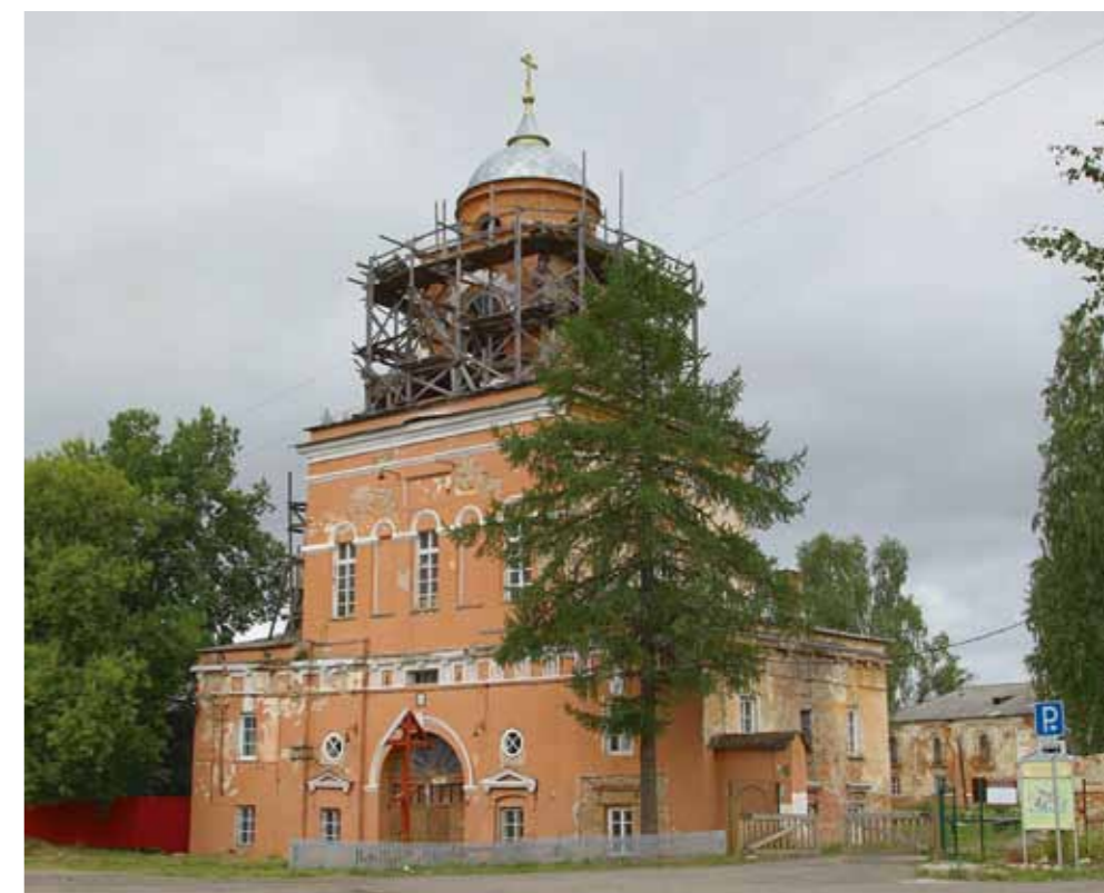
Вид на колокольню Введенского женского монастыря с северной стороны. 2017 г.
