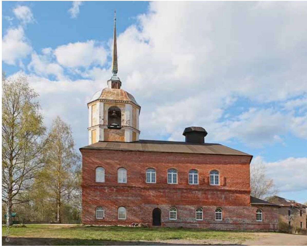
Троицкий собор. Южный фасад. 2017 г.
