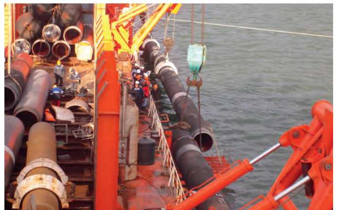
Строительство газопровода Бованенково-Ухта (полуостров Ямал)
