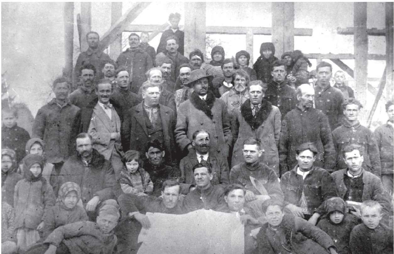
Брати Бахмати (стоять перший та п'ятий зліва) на будівництві школи в Добротіві
