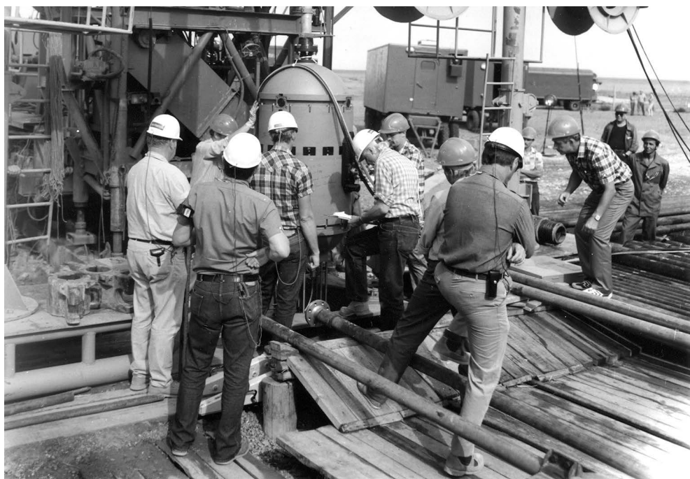
СЭК УП-2 скважина 1350 спуск контейнера с зарядом (14.09.1988 г.) фото В. Видякина
