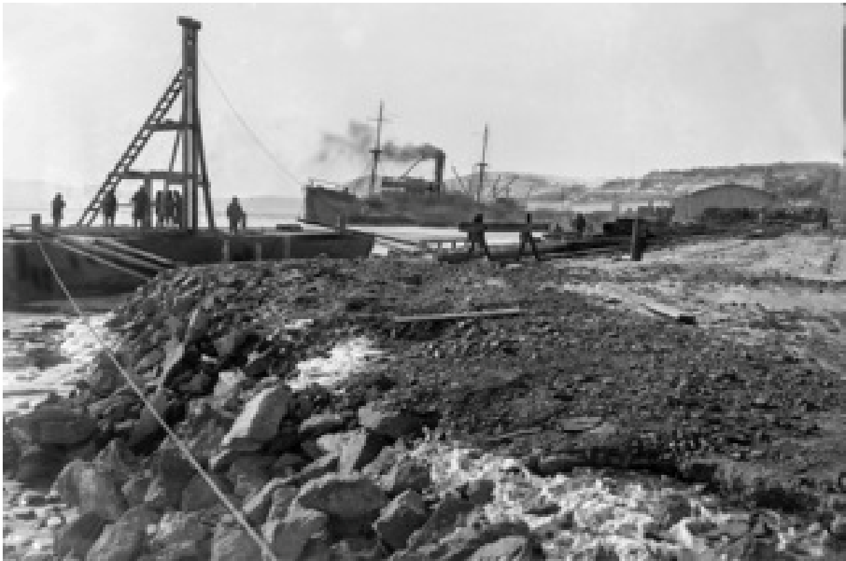
Фото 3. Строительство причалов на Эгершельде...
