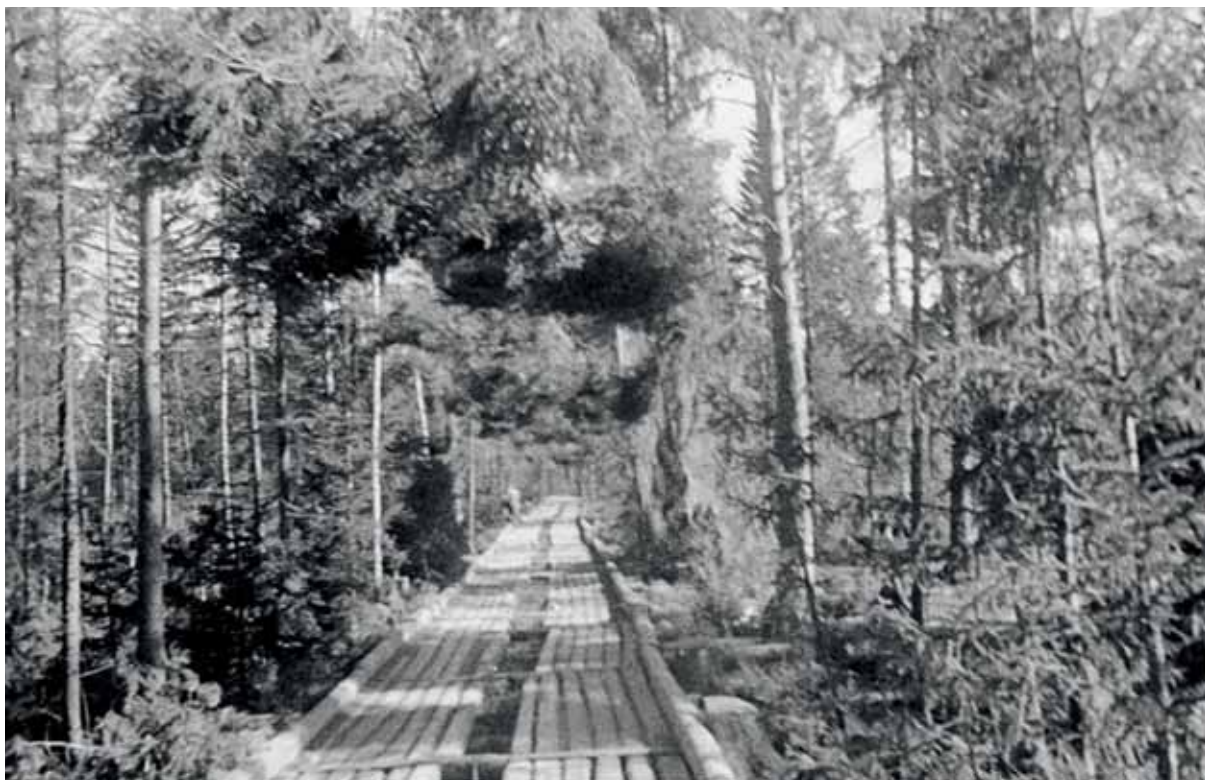
Лежневка, по которой доставляли боеприпасы и продовольствие на передний край. Северо-Западный фронт, 1942 г. (Российский государственный архив кинофотодокументов)
