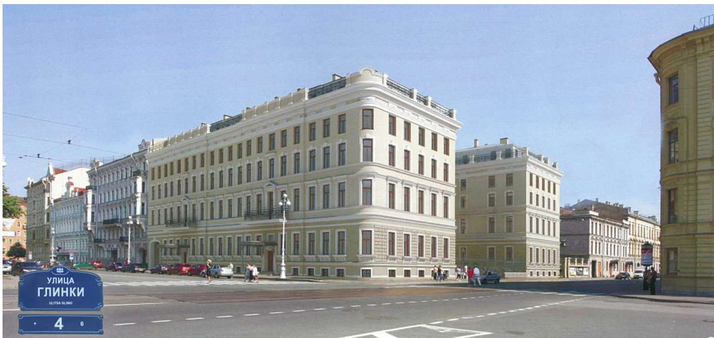
ДОМ АДМИРАЛА ГРАФА Н. С. МОРДВИНОВА, частым гостем которого в 1820-е гг. был С. Н. Аксенов. Изначально здание было трехэтажным, перестраивалось в 1867 г., надстроено в 1895 и в 1970–72 гг.
