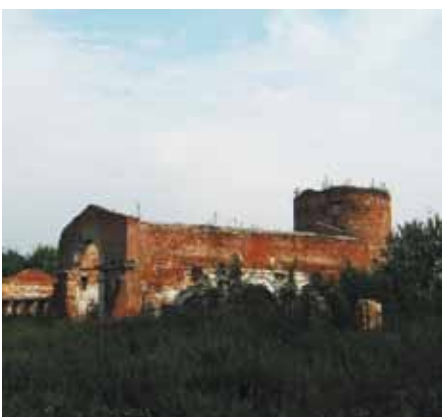
■ Руины хозяйственных построек
