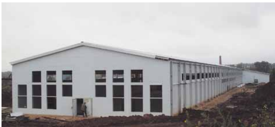
Новый, современный цех
