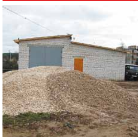
■ Строительство пожарного депо
