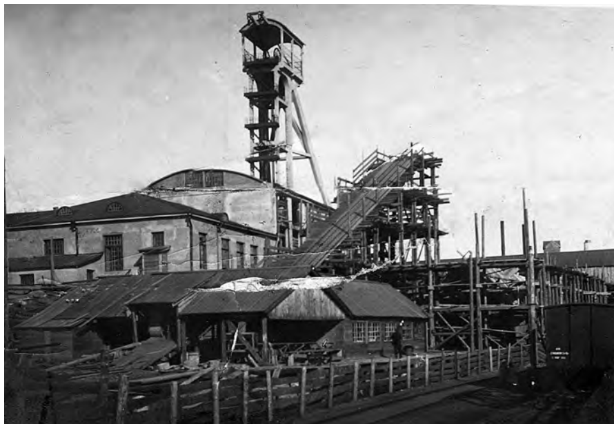
Железобетонный копер ствола шахты № 7 Судженских копей. 1934 // Анжеро-Судженский городской краеведческий музей. ОФ. № 11190
