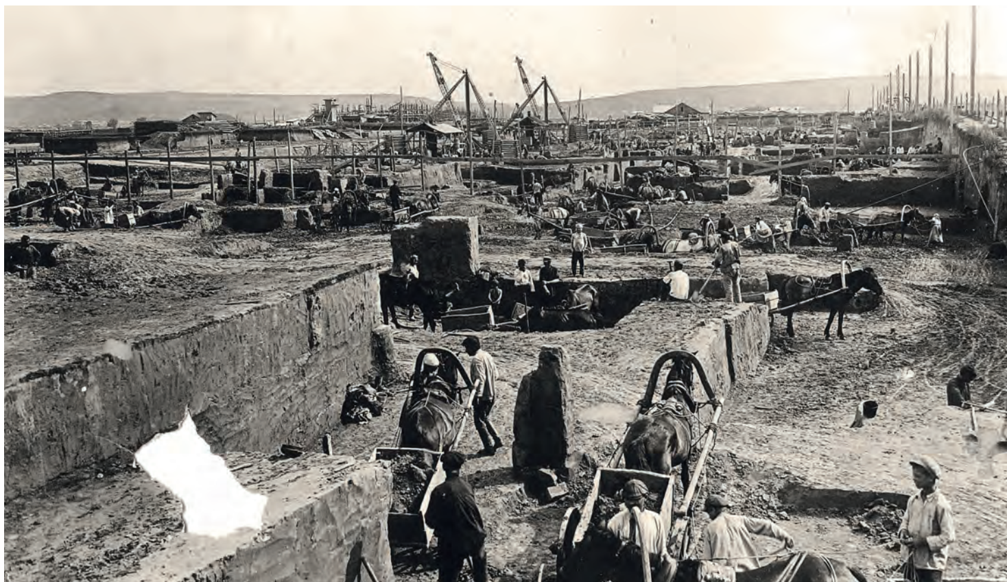
Земляные работы на Кузнецкстрое. 1930 // Томский областной краеведческий музей. № 9148/38
