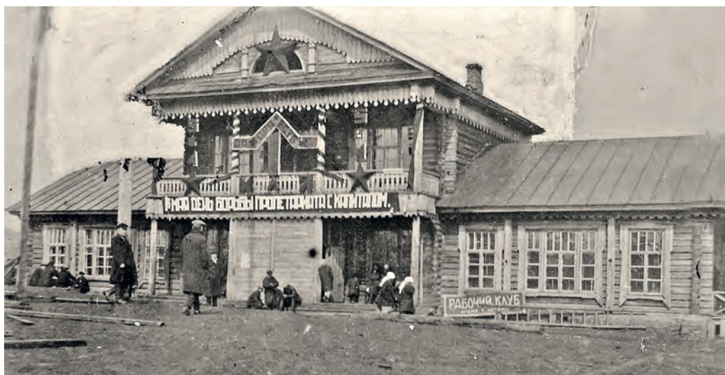
Здание клуба им. товарища Артёма в Прокопьевске. Фото 1920-х // Из фондов Прокопьевского краеведческого музея. Здесь проводились партийные собрания, уроки политграмотности и т. д.
