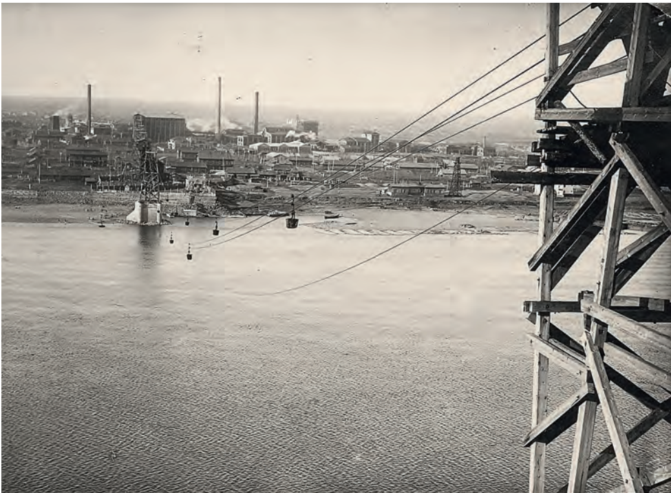
Канатная дорога через реку Томь для перевозки угля из Кемеровского рудника на коксохимический завод // ГАК. Ф. Фотофонд. Оп. 8. Д. 749
