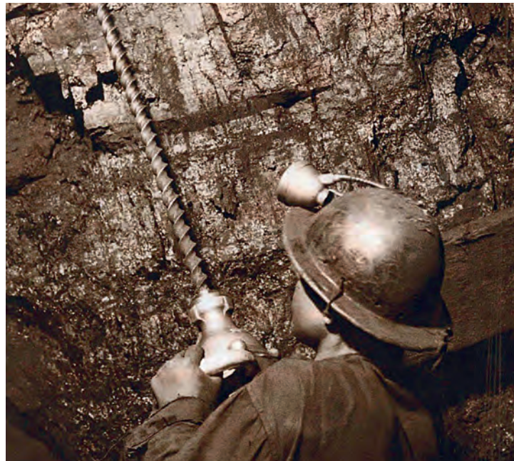
Добыча угля на шахтах Кузбасса с помощью электросверла // СССР на стройке. 1935. № 2 (февраль)
