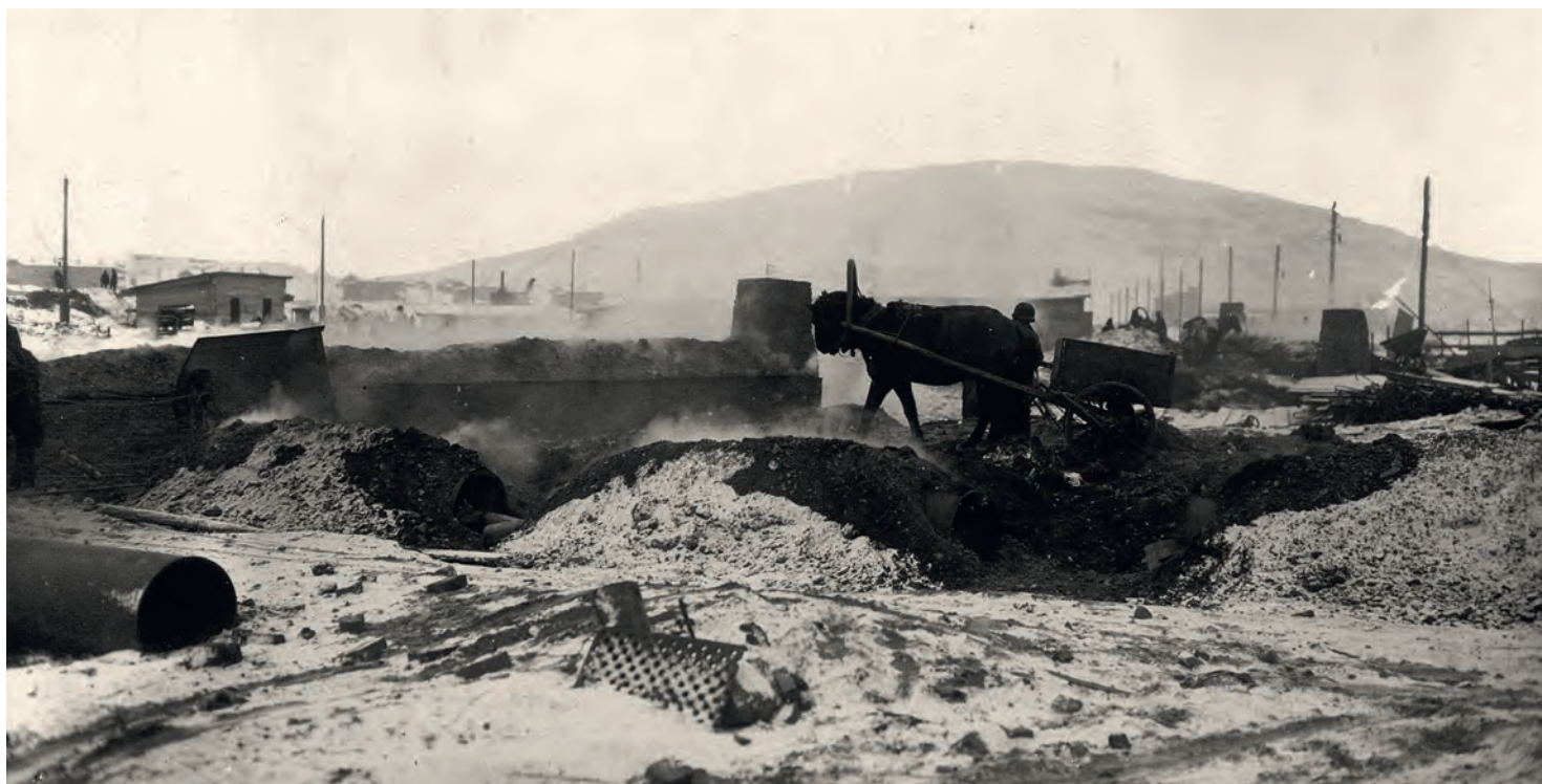
Зимние работы на мартеновском цехе. 1931 // Томский областной краеведческий музей. № 9148/39. На фото виден пар, поднимающийся от теплой земли
