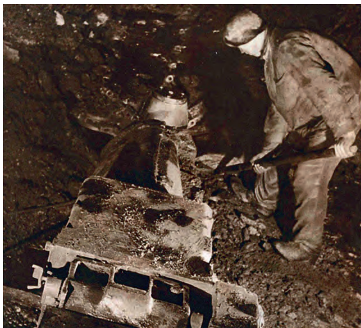
Добыча угля на шахтах Кузбасса с помощью врубовой машины // СССР на стройке. 1935. № 2 (февраль)
