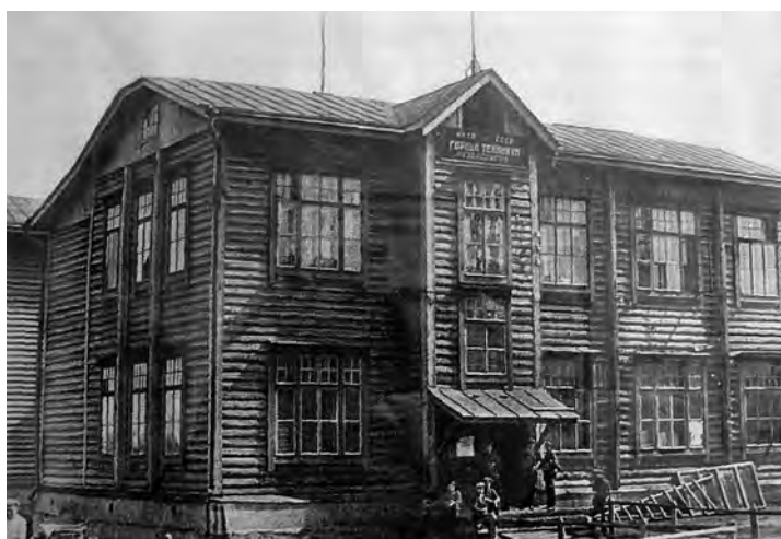
Первое деревянное здание Анжеро-Судженского горного техникума // Из фондов музея Анжеро-Судженского горного техникума
