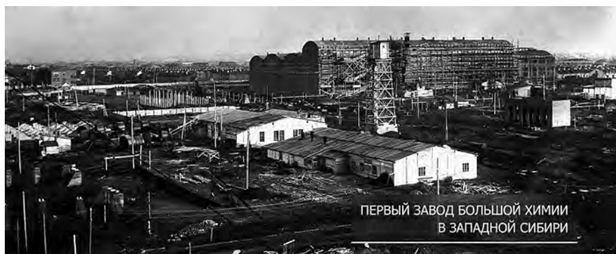
Строительство азотно-тукового завода в Кемерове, 1930-е // Из фондов музея истории завода «Химпром»
