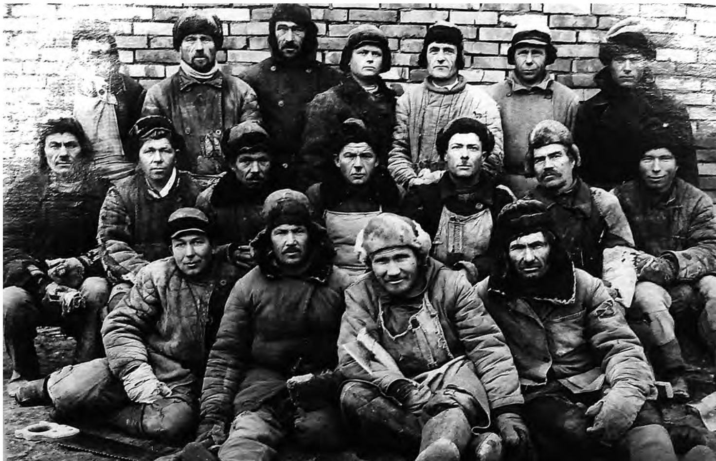
Бригада рабочих на постройке углеперегонного завода в Кемерове. 30 октября 1934 // Из фондов музея истории завода «Химпром»
