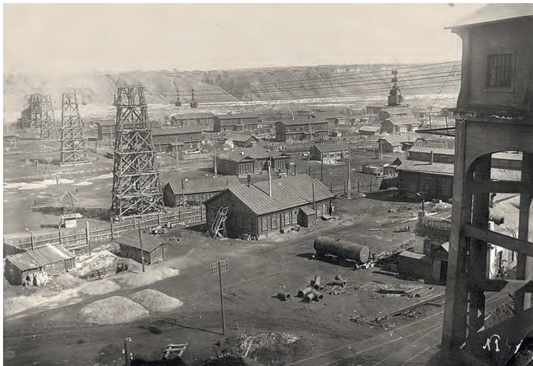
Канатная дорога через реку Томь для перевозки угля из Кемеровского рудника на коксохимический завод // ГАК. Ф. Фотофонд. Оп. 8. Д. 749
