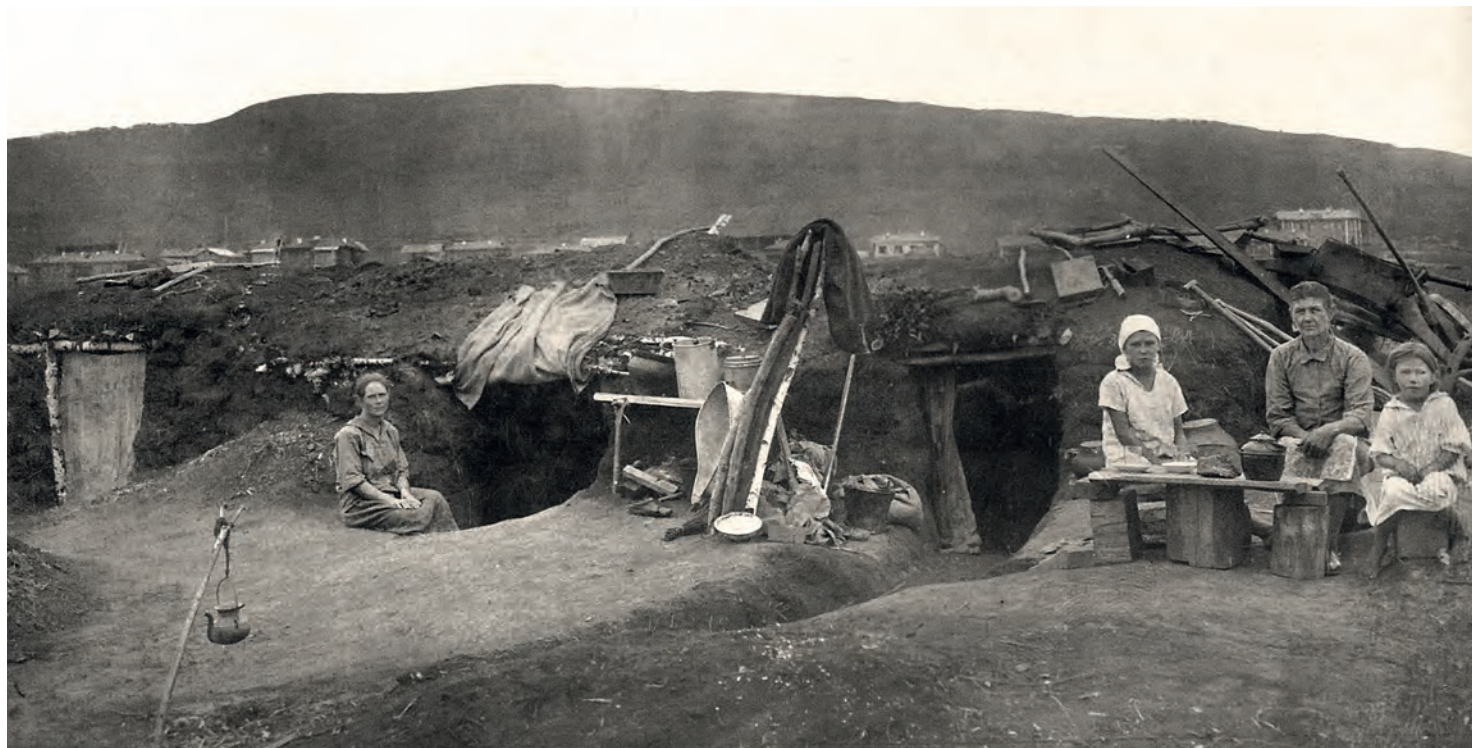
Временные землянки рабочих Кузнецкстроя. 1929 // 75 лет КМК–НКМК. Фотоальбом. Новокузнецк, 2007
