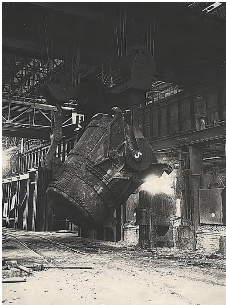
Разливка чугуна на КМК // Томский областной краеведческий музей. № 9148/40
