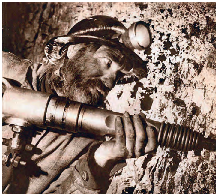
Добыча угля на шахтах Кузбасса с помощью отбойного молотка // СССР на стройке. 1935. № 2 (февраль)
