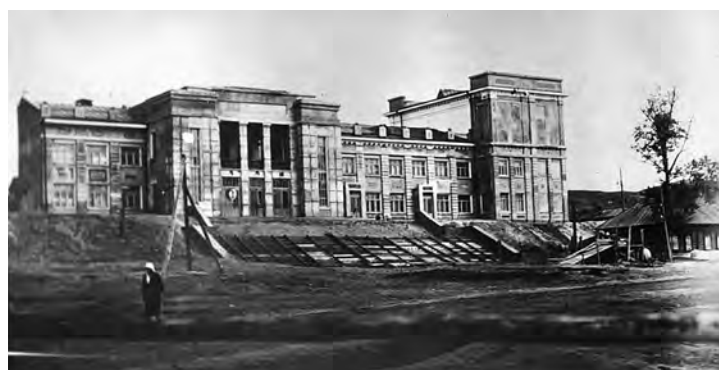
Строительства Дома культуры Гурьевского металлургического завода. 1935 // Гурьевский городской краеведческий музей. Оф. № 3138
