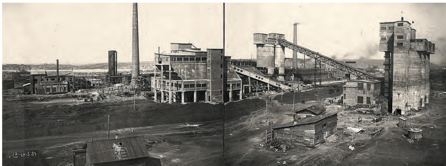
Панорама строительства нового коксохимзавода в Кемерове. 1934 // ГАК. Ф. Фотофонд. Оп. 8. Д. 773
