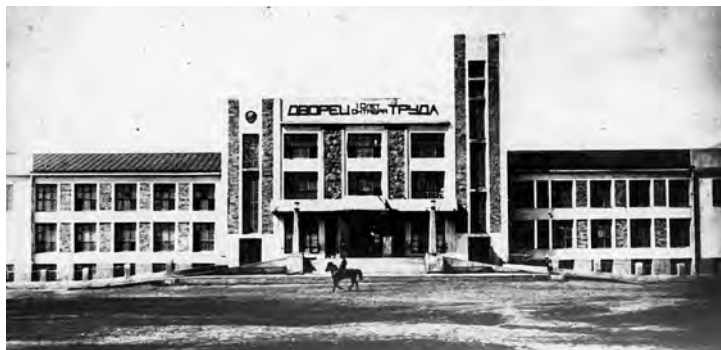
Дворец труда в Щегловске. Начало 1930-х // Захарова И. В. Кемерово: город-сад – соцгород – город-ансамбль. Градостроительство и архитектура 1910–1950-х годов. Кемерово, 2020. С. 28
