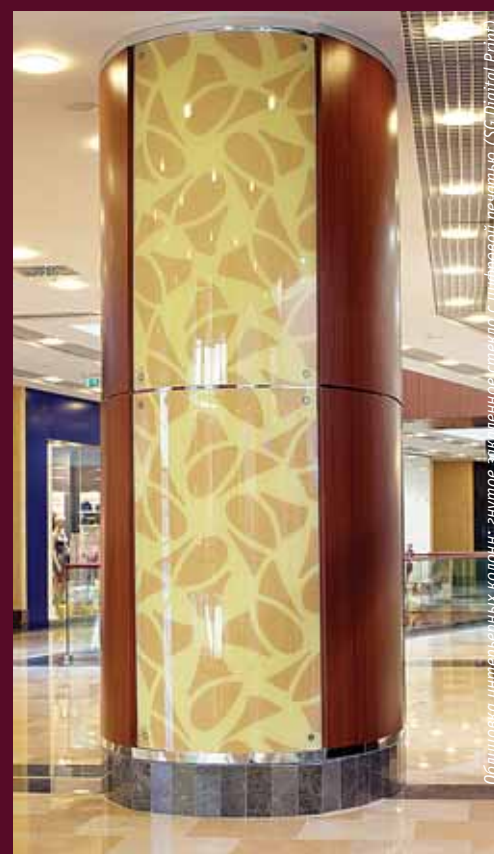
Облицовка внешних корпусов эскалаторов: стемалит (GSG Col Ral 7034, Ral 5024, Ral 8020), перегородки и витрины: закаленное стекло 12 мм и 10 мм
