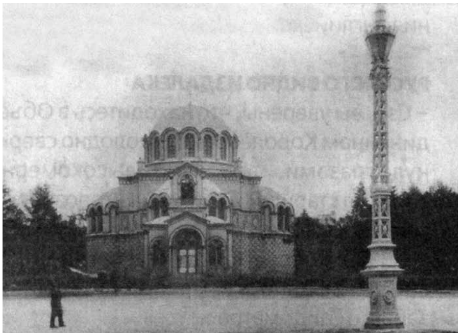
Греческая церковь в Санкт-Петербурге
