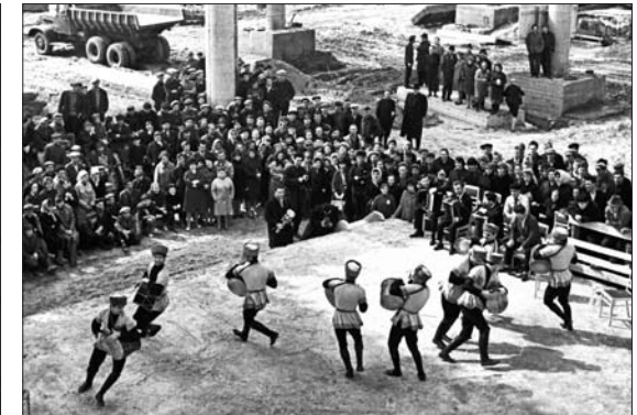
Лезгинка на строительной площадке Ленинского мемориала. Фото Б. Г. Тельнова. 1968 год
