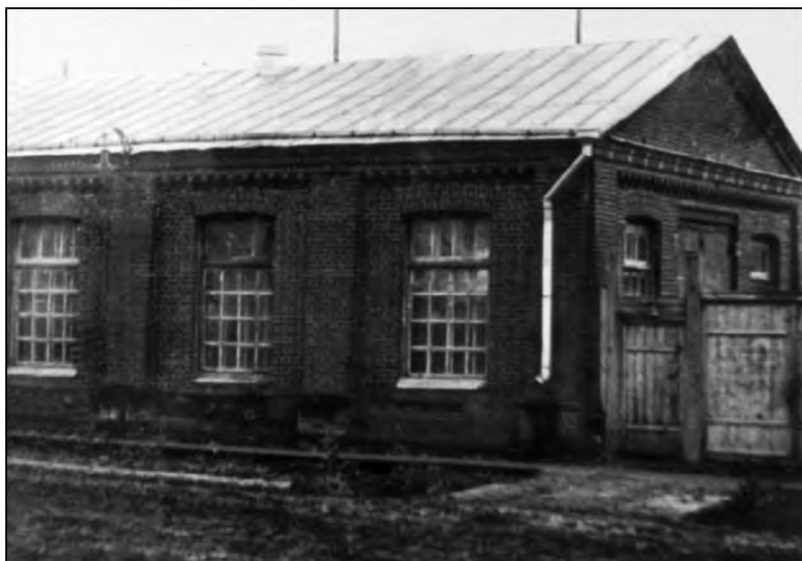
Здание электростанции. Начало XX в.
