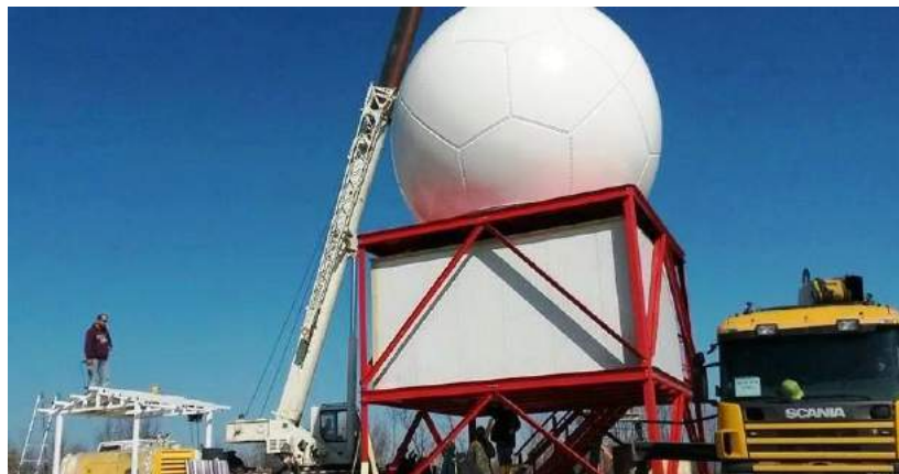
Рис. 3 Монтаж радиолокатора Meteor 735CDP10.
