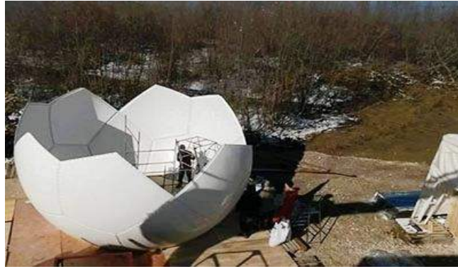
Рис. 2 Сборка защитного купола радиолокатора Meteor 735CDP10.
