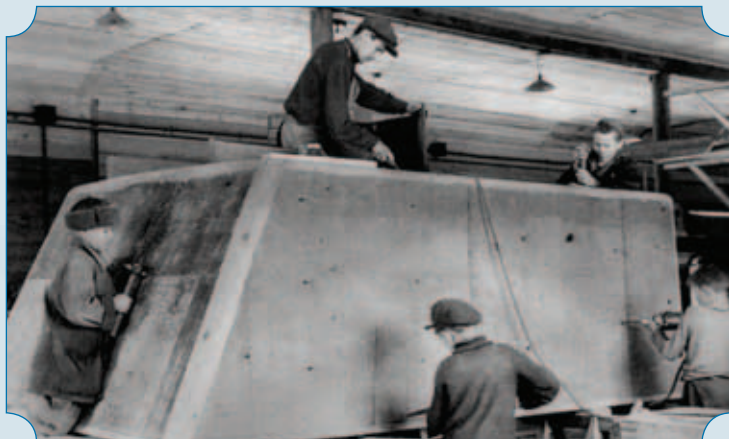
Момент поточно-позиционной сборки катеров на Сосновской судовой верфи (Кировская область). 1943 г.
