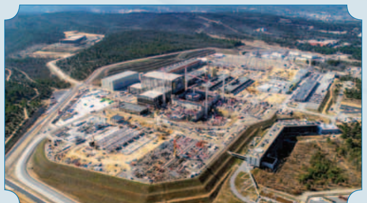
Площадка строительства Международного экспериментального термоядерного реактора ИТЭР (Кадараш, Франция)
