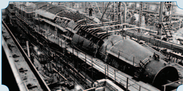
Формирование корпуса АПЛ пр.671 в цехе Адмиралтейского завода
