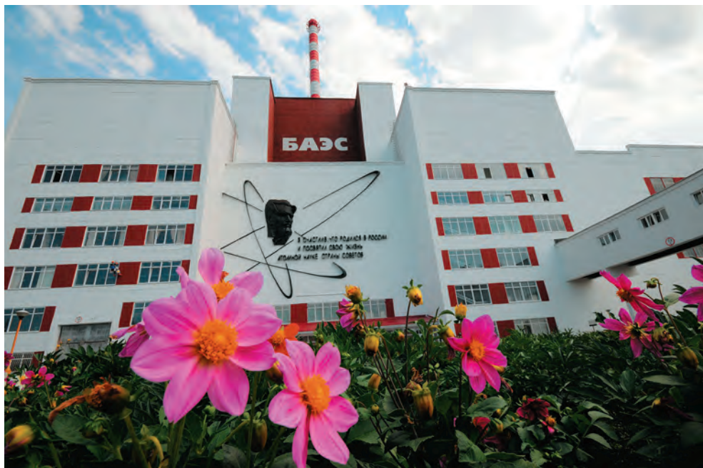
Здание главного корпуса 1-й очереди Белоярской АЭС (фото Сергея Тен)
