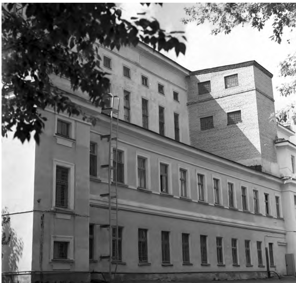
Корпус здания реактора «АИ»
