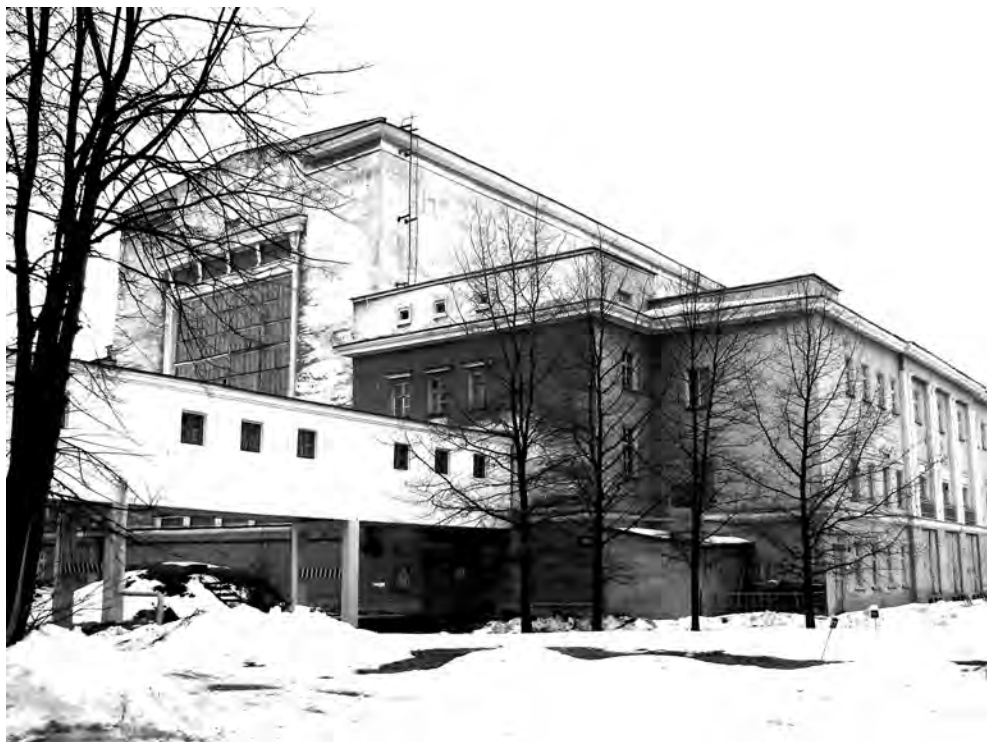
Здание реактора «АВ-1»
