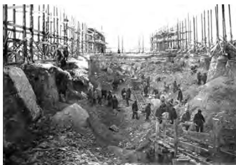
Заключенные ИТЛ на земляных работах в котловане для реактора «А»
