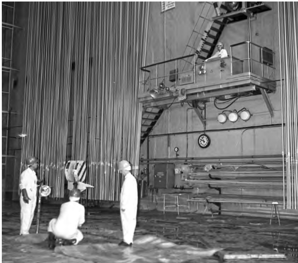
Центральный зал реактора «А»
