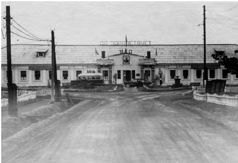
Здание строительного управления № 859
