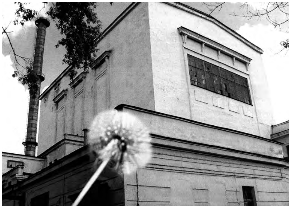
Корпус центрального зала реактора «А»
