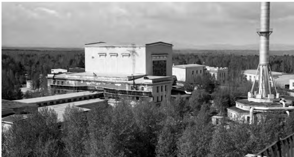
Комплекс зданий реактора «А» (здания 1, 5, 15, 16)
