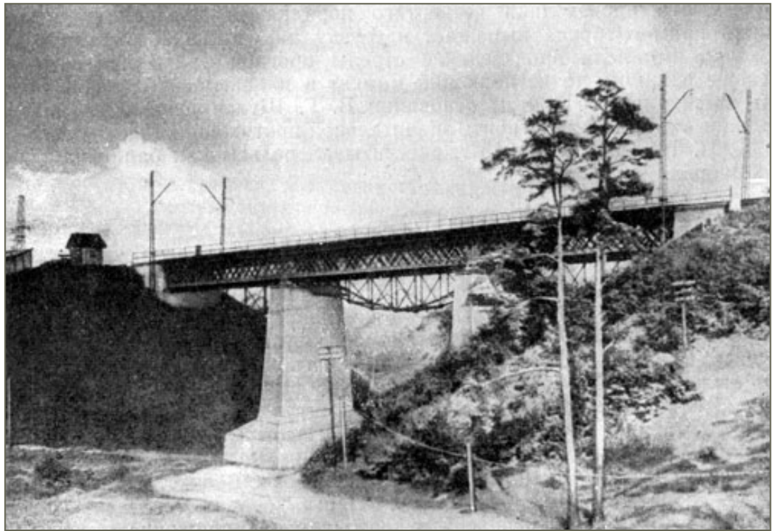
85. Многораскосный железнодорожный мост на Ярославской железной дороге у Хотькова, построенный по проекту инженера А. С. Рехневского
