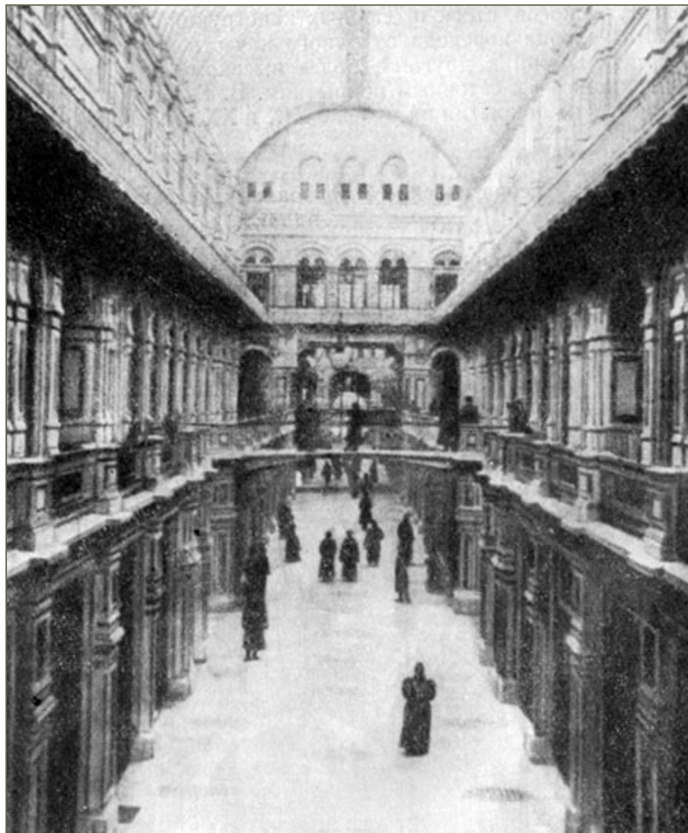
83. Остекленное перекрытие здания Верхних торговых рядов (ныне ГУМ) в Москве
