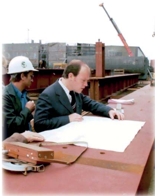
На заводе металлоконструкций компании «Раума — Репола» в Калаёки. Приёмка металлоконструкций для строящейся фабрики окомкования Костомукшского ГОКа, 1979
