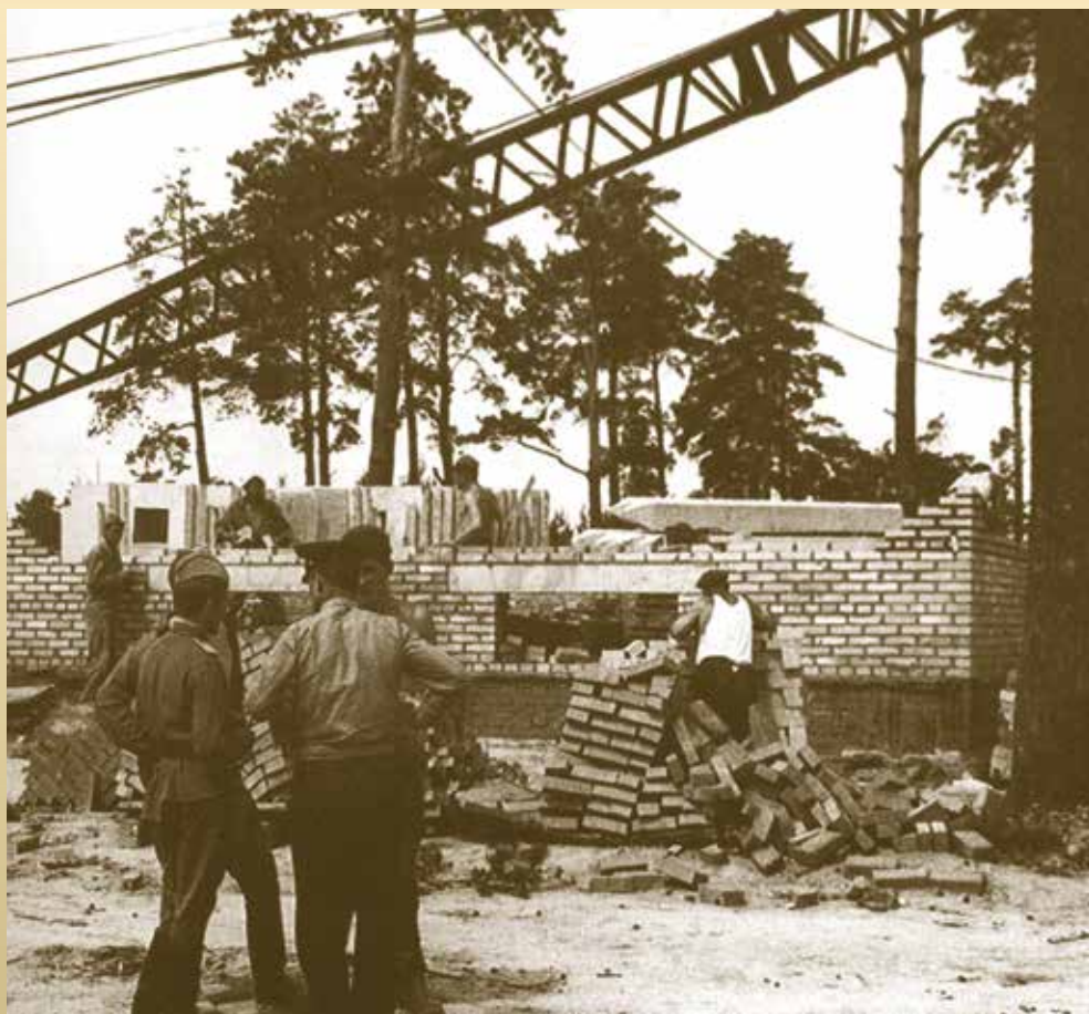
Первые кирпичи и первые этажи будущего госпиталя в Красногорске. 1965 г.
