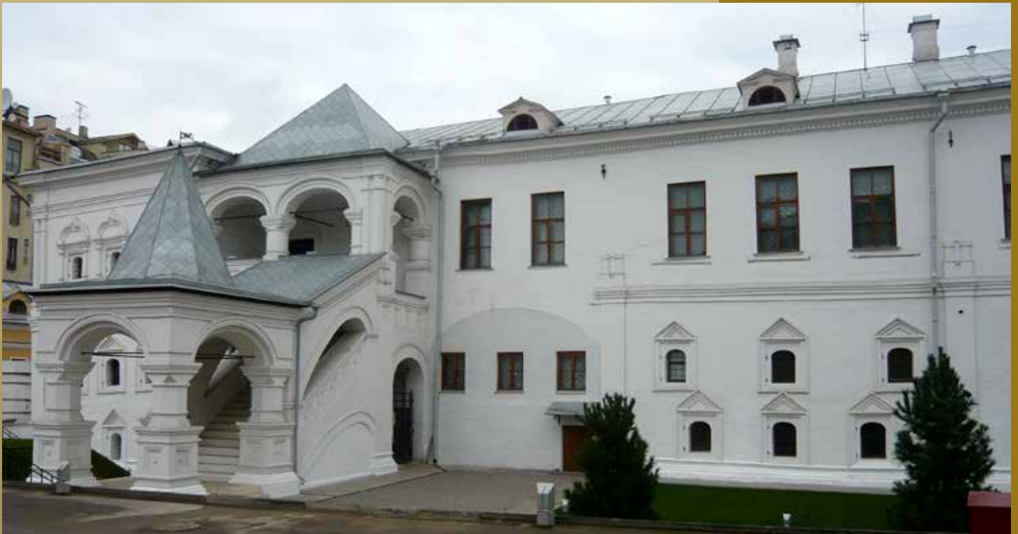
«Усадьба двух эпох...» Малый Знаменский переулок, д. 3. Усадьба Лопухиных XVII века. Вид со стороны двора. 2013 г. Фото авторов
