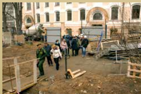
Инспектирование стройки проводят заместитель начальника ГВМУ МО РФ генерал-майор медицинской службы Власов А.Ю. и начальник медицинского центра Гришина О.В. 2015 год
