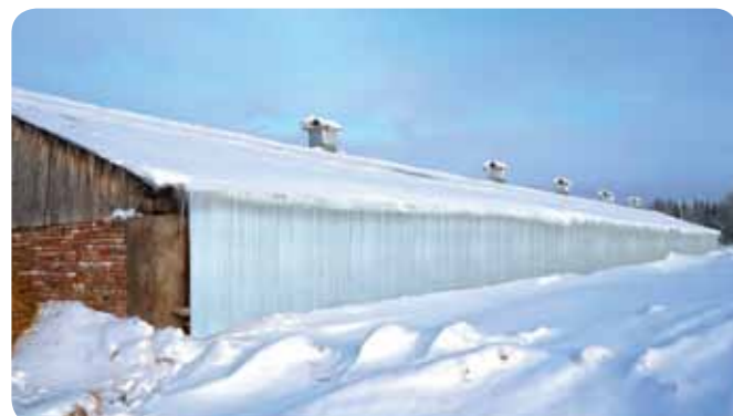
На молочно-товарной ферме в Петровцах выполнили капитальный ремонт двора, поменяли крышу.
