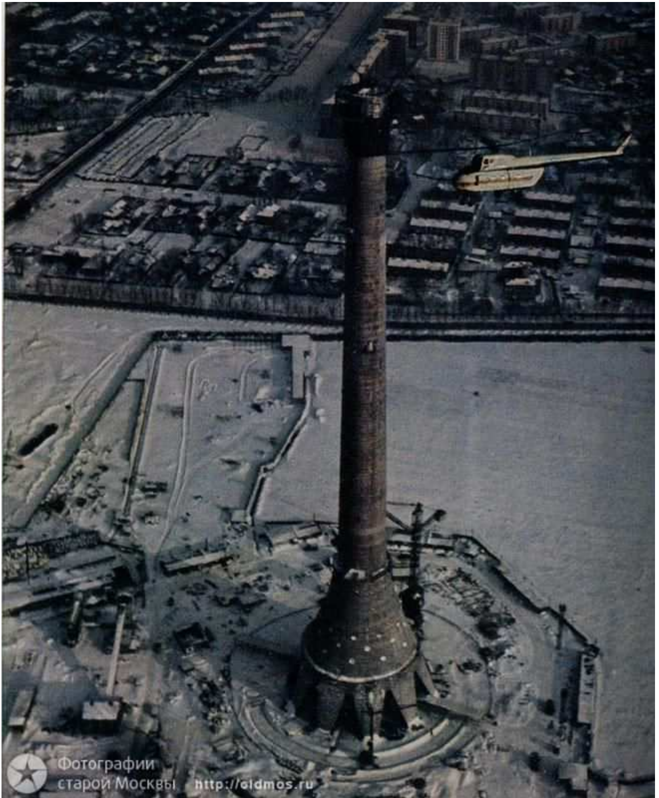
Рис. 9. Останкинская телебашня г. Москва [7]
