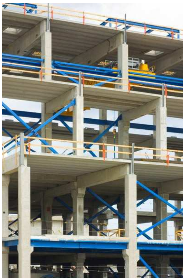
Рис. 46. Возведение здания из сборно-монолитного железобетона [34]
