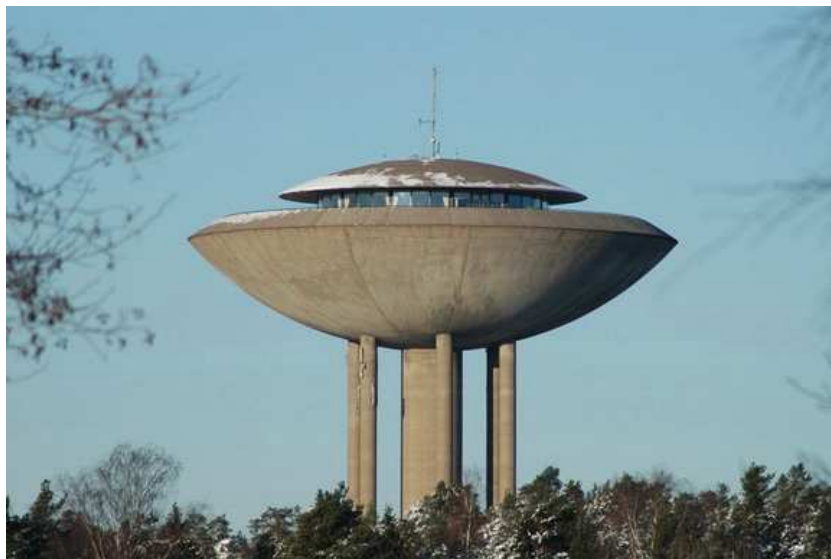
Рис. 84. Водонапорная башня города Хаукилахти (Haukilahti), Финляндия [42]
