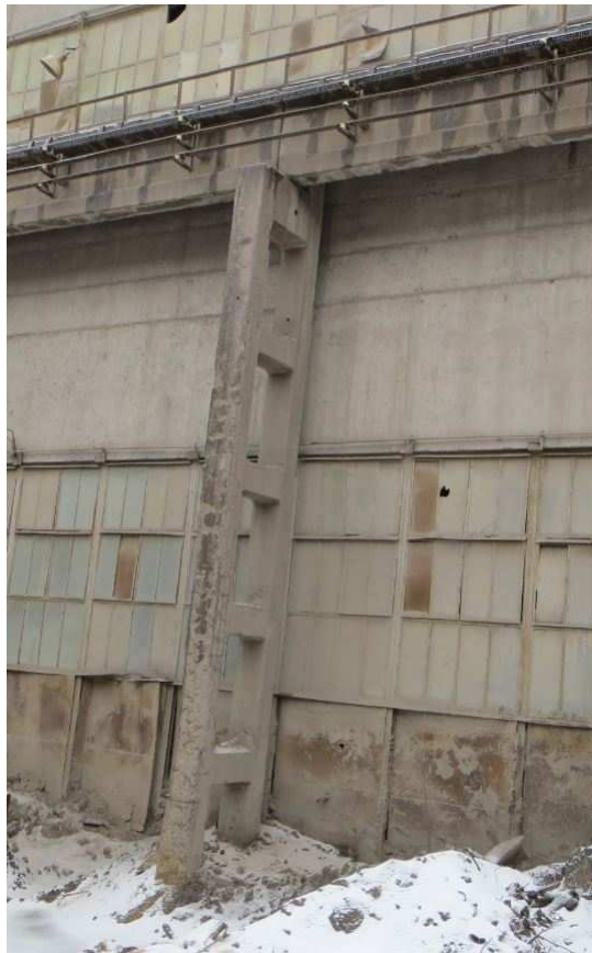
Рис. 37. Сборная железобетонная колонна крановой эстакады
