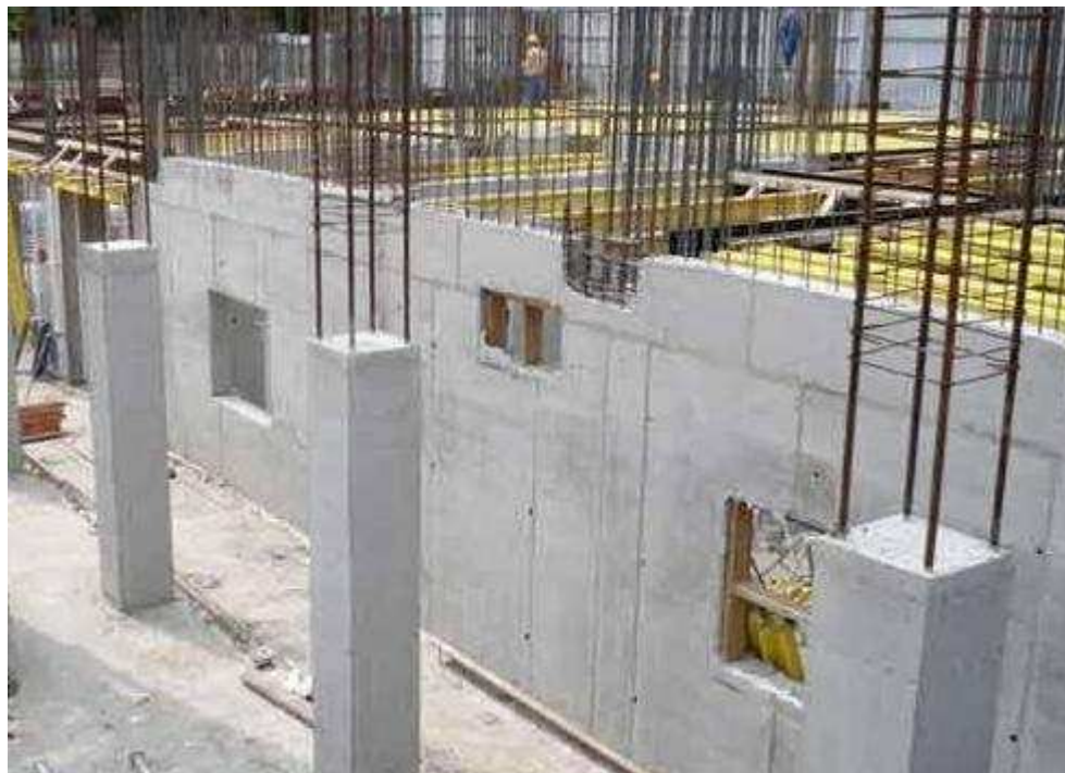
Рис. 45. Возведение здания из монолитного железобетона [33]
