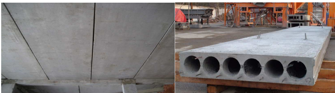
Рис. 60. Панельное балочное перекрытие из многопустотных плит [36], [57]
