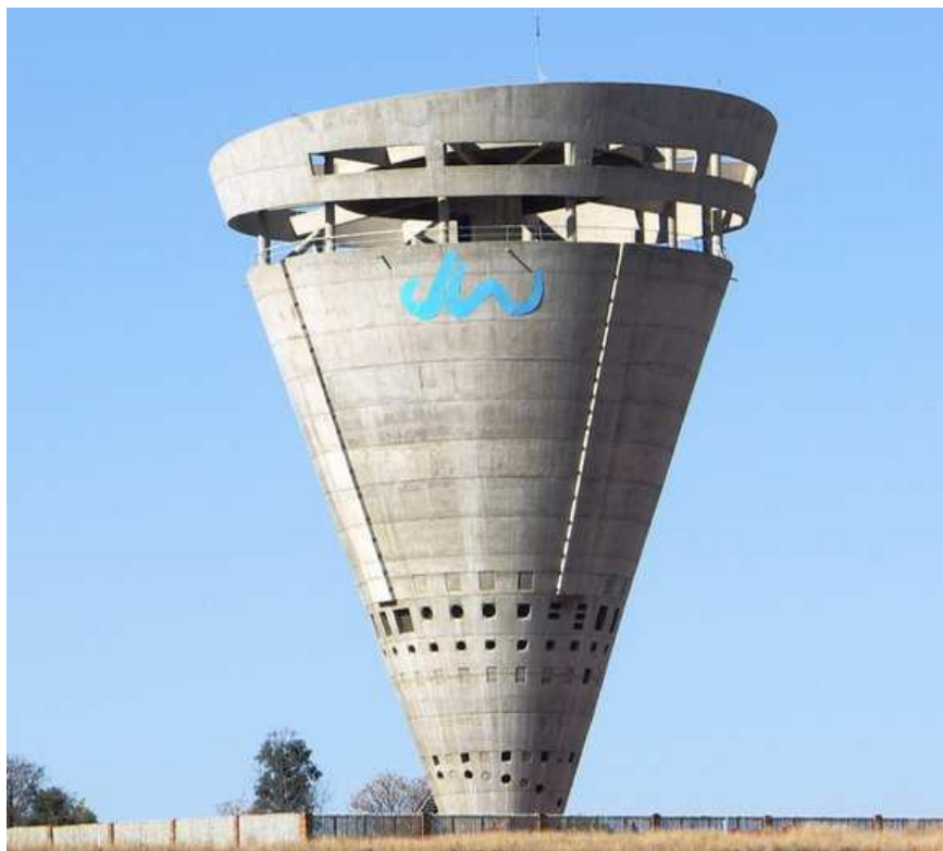
Рис. 83. Водонапорная башня Мидранд (Midrand), Южная Африка [42]
