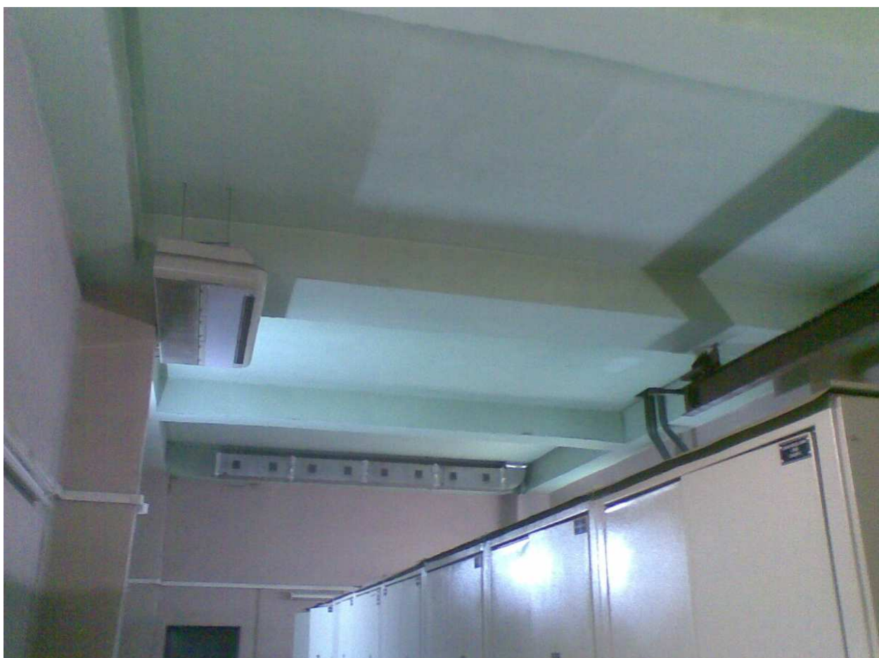
Рис. 62. монолитное ребристое перекрытия с балочными плитами
