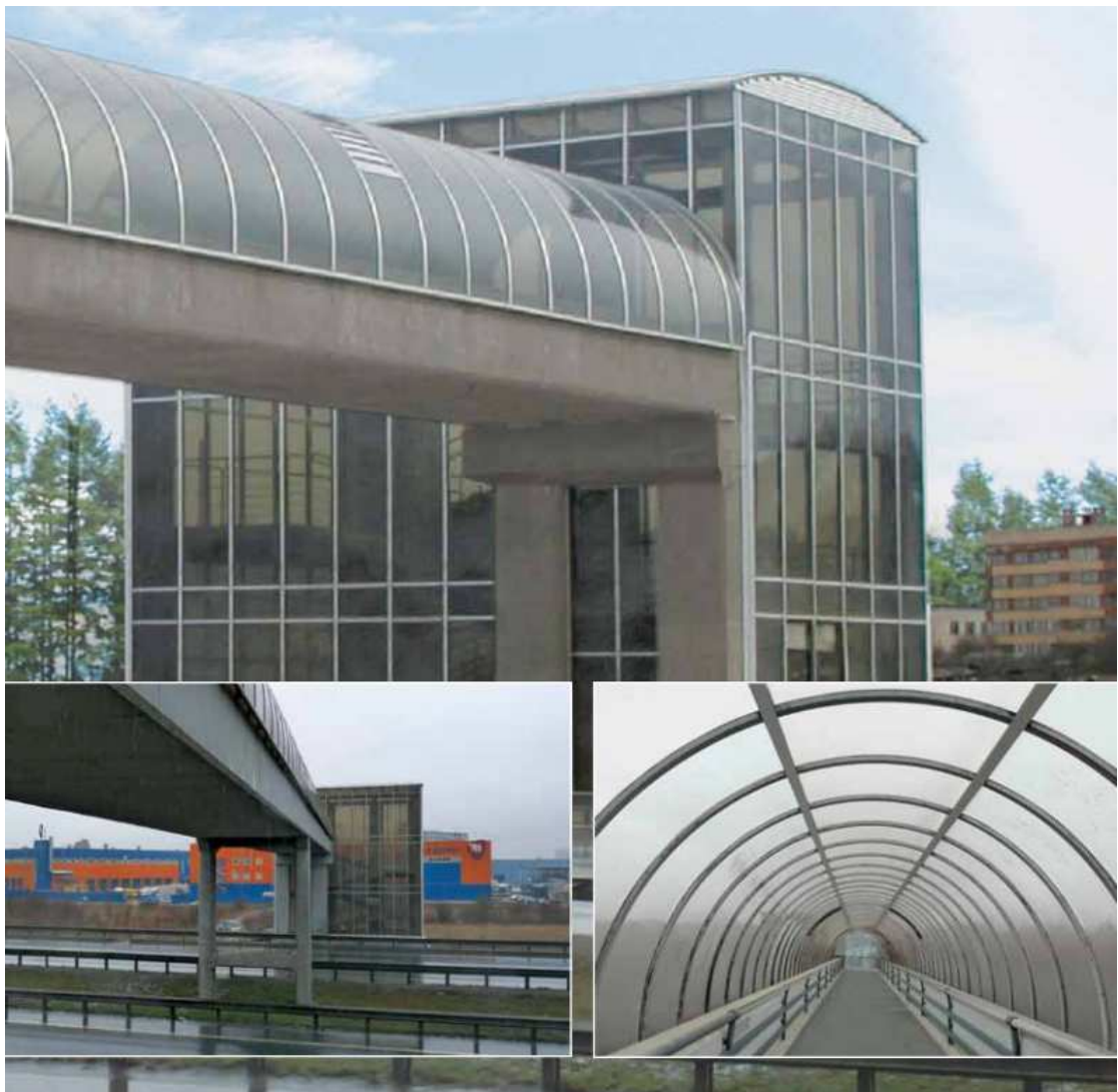
Рис. 88. надземный пешеходный переход под Пискаревским пр. в створе улицы Куракина в Г.Санкт-Петербурге (Пешеходные переходы ЗАО «Институт Гипростроймост Санкт-Петербург»). [45]
