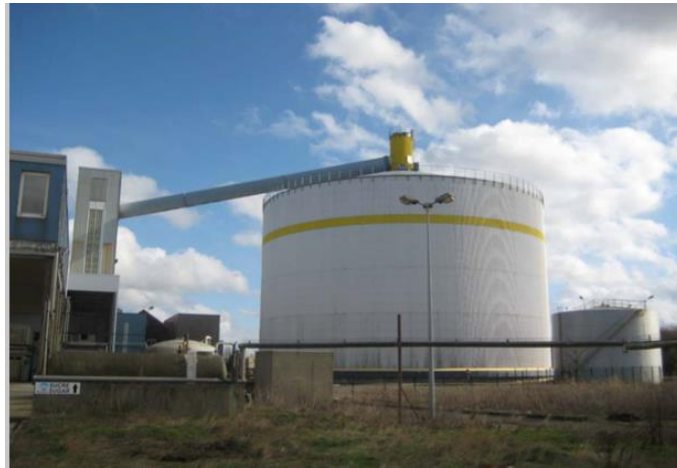
Ilustración 3-44: Silos de Azúcar [16]
