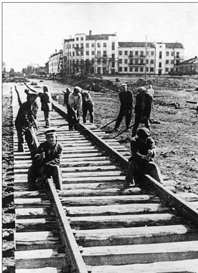
Строительство трамвайной линии на Октябрьской улице города Кирова. 1942 г.
